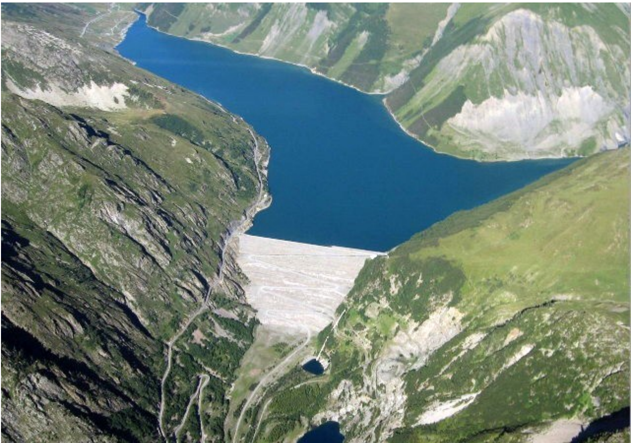
Une partie de la STEP de Grand Maison, en France.
